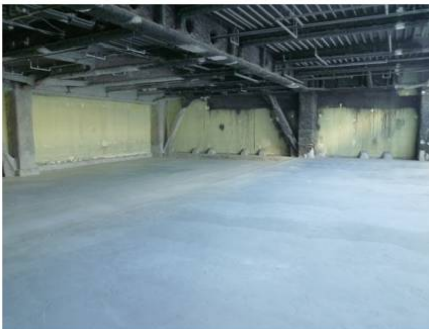
全景①(北西側)
